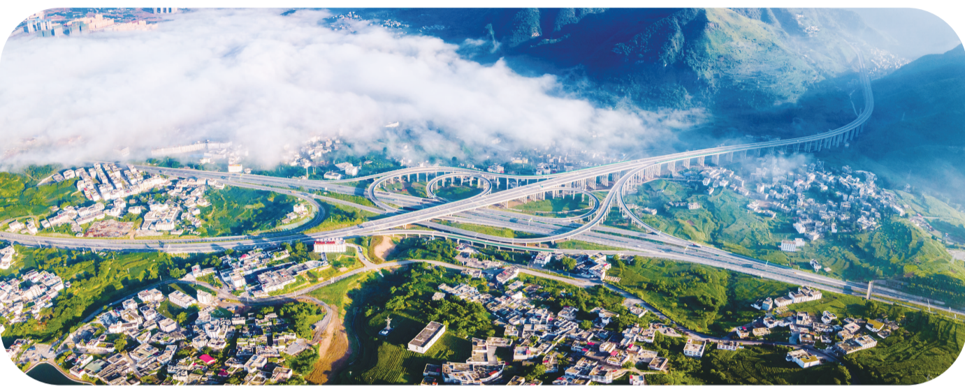
镇雄县陈贝屯高速公路立交桥。
