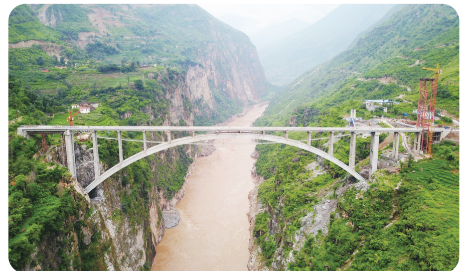
2018年7月10日,巧家县茂租镇鸚哥溜索改桥项目鸚哥大桥建成通车。闫科任 摄
